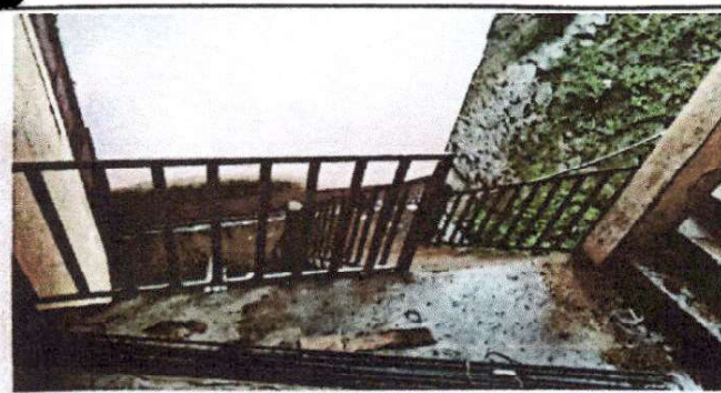
Foto 5: sustitución de barandas
