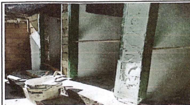
Foto 4: aplicación de repello para servicio sanitario
