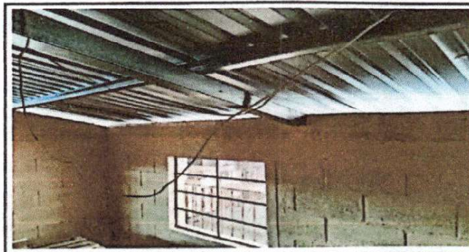
Foto 6: reparacion de sistema electrico
