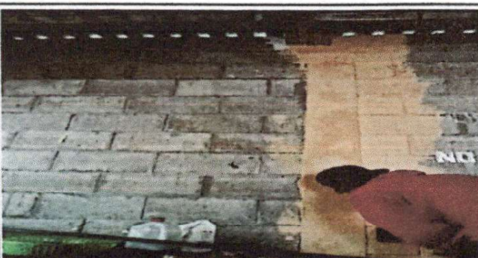
Foto 9: pintura en muros exteriores e interiores
