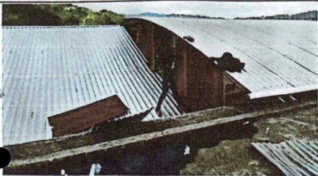
Foto1: sustitución de lanima por lamina troquelada aluzinc calibre 26
